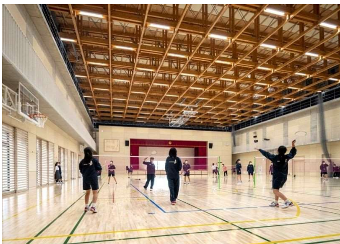
体育館（RC 造・鉄骨造＋木造屋根）
