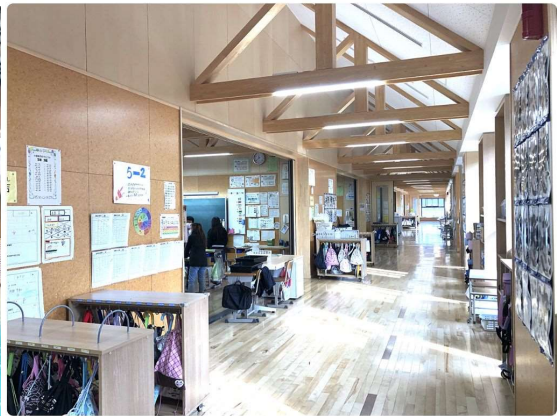
廊下側の壁を開放できる構造
