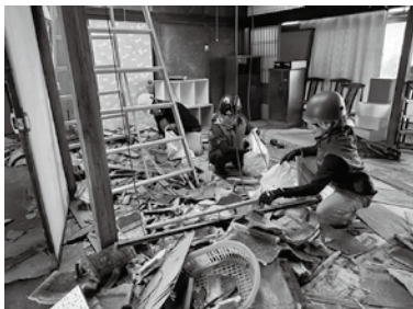
瓦が屋内に落ちて、部屋から空が見える状況であったため、屋根の修理と家屋内の瓦撤去を実施
