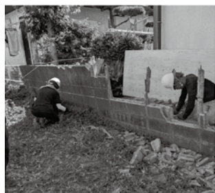
傾いたブロック塀の解体作業
