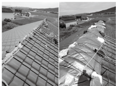
大屋根の陸棟と下り棟へのシルバーシート張り、下屋の平瓦の差し替え
