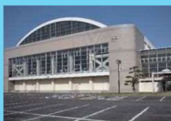
町総合体育館
