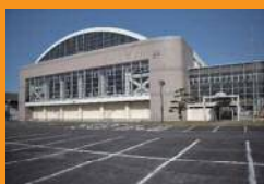
町総合体育館
