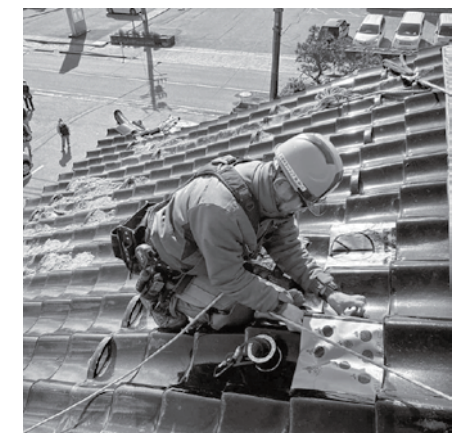
▲「段ボール瓦」で屋根の応急処置
