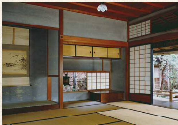
▲ 座敷「上の間」床・床縁(高巻木付)・南広縁・露台
