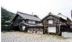
▲ 旧内田佐平二家住宅 主屋・東面透廊・隠居屋・土蔵
