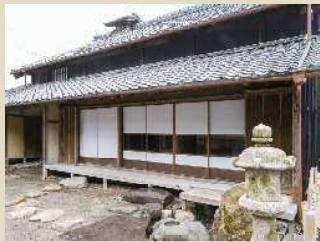
▲ 主屋北面前外観
