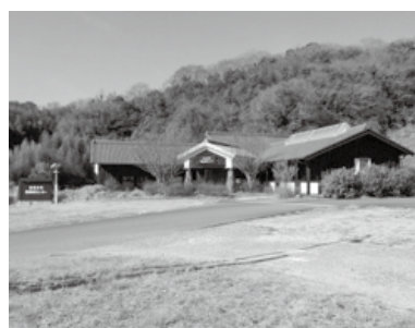
【豊浜防災センター】
