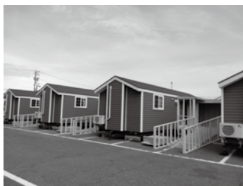
<トレーラーハウス>
