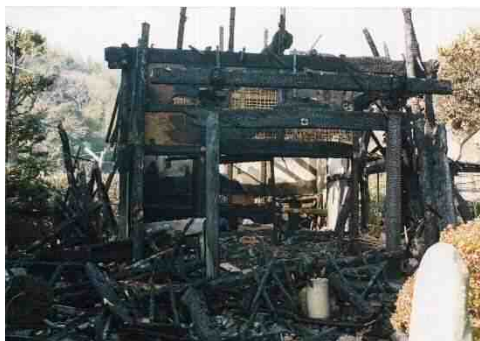
弘法堂の被害状況
