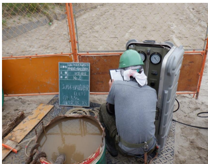
孔内水平載荷試験
