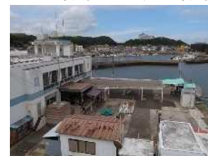
観光センターの浄化槽 等
