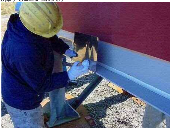
チタン箔シート貼り付け状況
