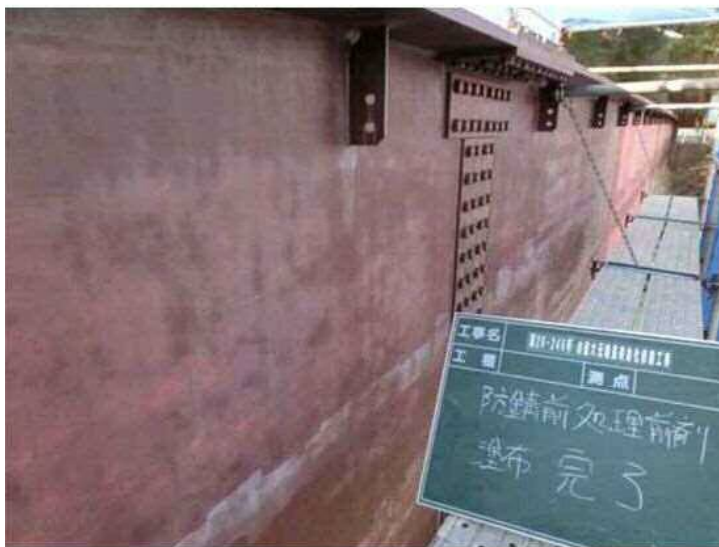
耐候性鋼材への塗装
