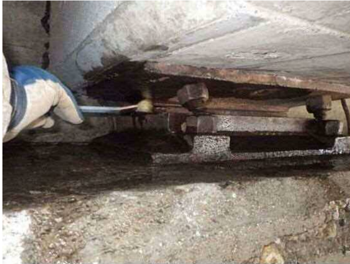
支承部への塗装
