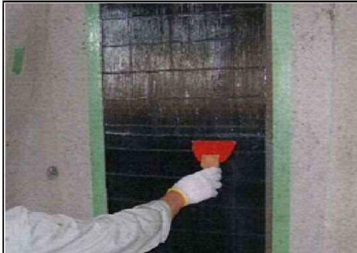
ストランドシート貼付工
