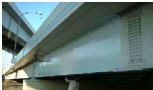
塗装後の外観
