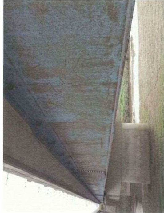
評価 3 (部分的にさびが見られる。ここでのさびの発生割合約 4%)
