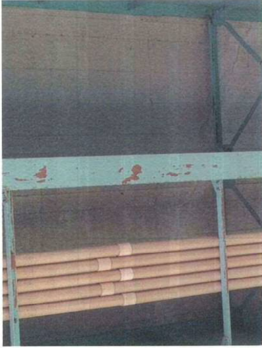
評価 3 (部分的にはがれが見られる。ここでののはがれの発生割合約 7%)
