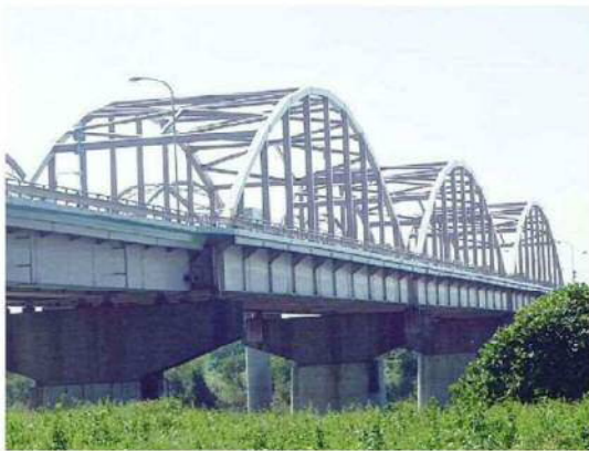
施工例（刀水橋 利根川に架かる橋）
