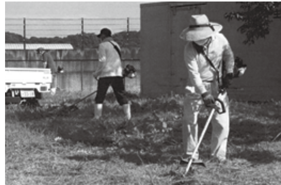
片名区：補助金で購入した資機材を使用した避難路整備
