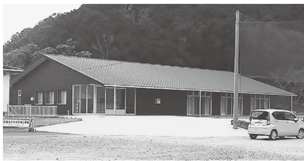
内海防災センター
