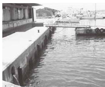
日間賀漁港陸揚岸壁
