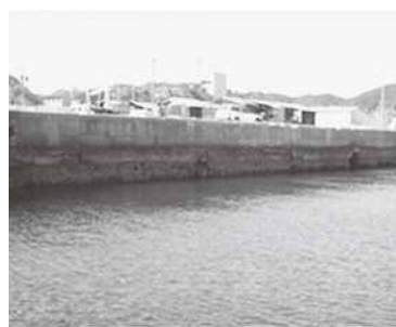
大井漁港物揚場
