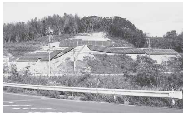
建設中の太陽光発電施設 (内海樫木交差点付近)
