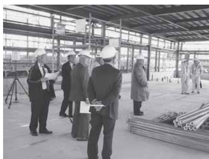
「日間賀島渡船施設」視察の様子
