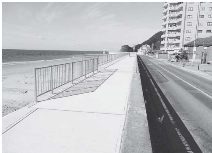
完成した山海海岸護岸上部
