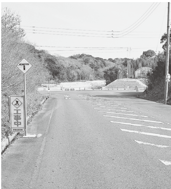
すいせんロードから工事中の県道奥田内福寺南知多線を望む
