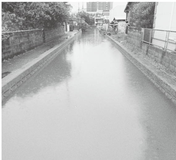
工事未施工箇所
