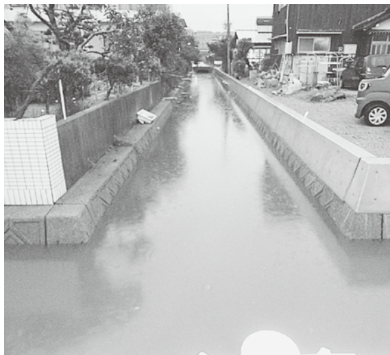
工事完了箇所
