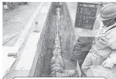
内海配水区管路耐震化工事
