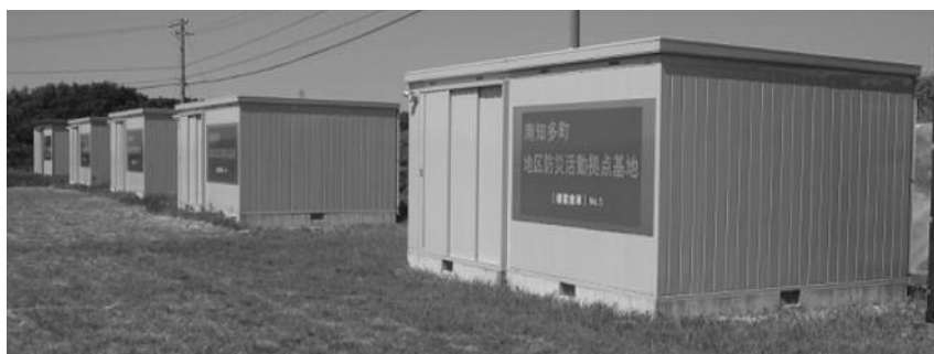
旧新運動公園用地（豊丘）に整備された備蓄倉庫
