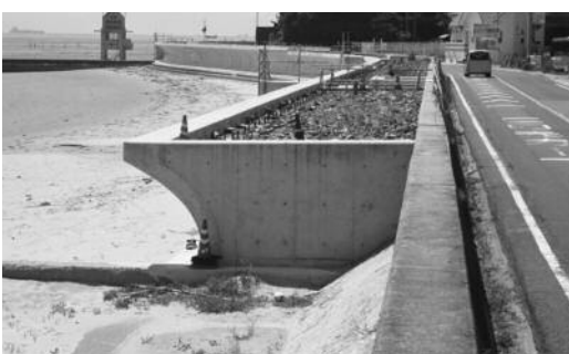
整備が進められているフレア護岸
