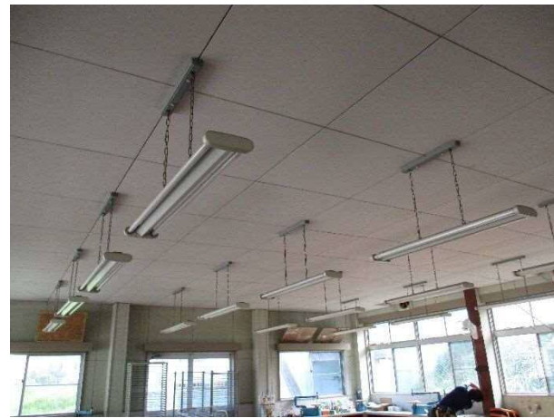
【②現況写真】
