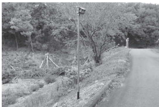
小野区：夜間照明設置
