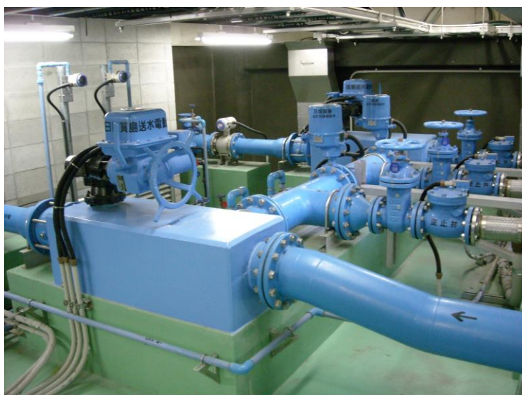
師崎ポンプ場内部
