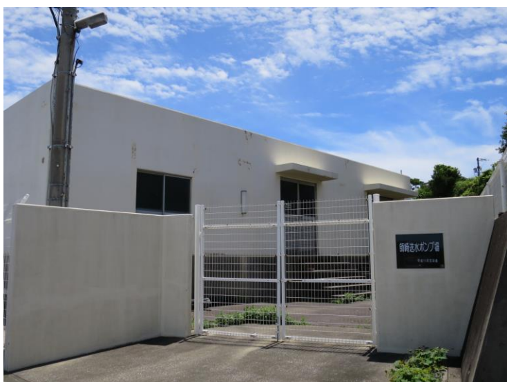
師崎ポンプ場
