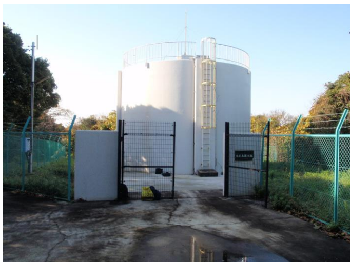
佐久島配水場
