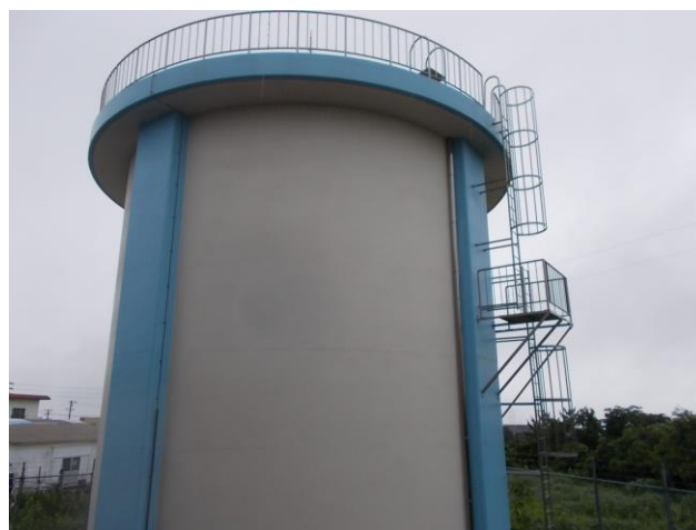
日間賀島配水場
