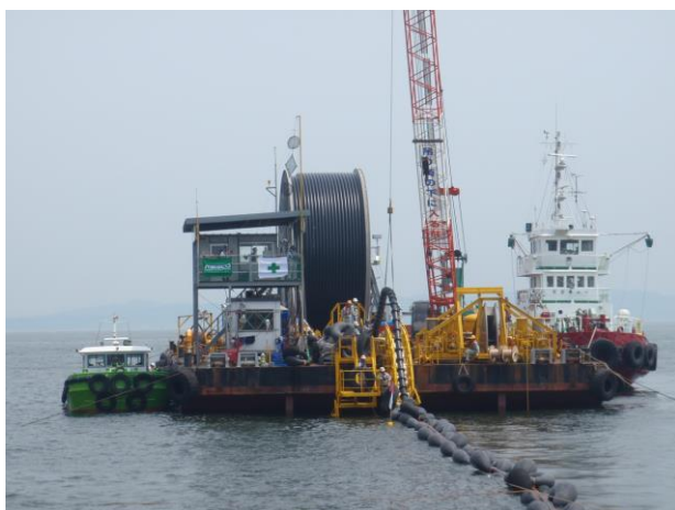
海底送水管布設
