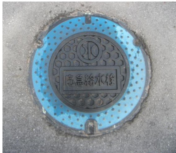
応急給水栓（内海小学校）
