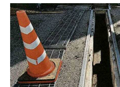
ひび割れ段差ができた舗装の修繕
