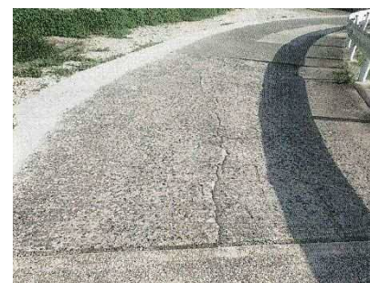
ひび割れ段差ができた舗装の修繕
