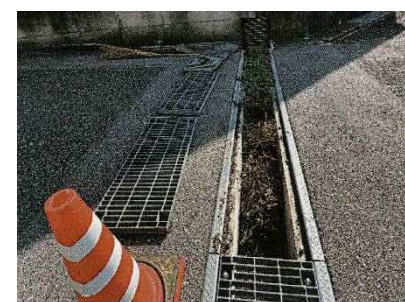
ひび割れ段差ができた舗装の修繕
