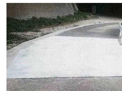
ひび割れ段差ができた舗装の修繕
