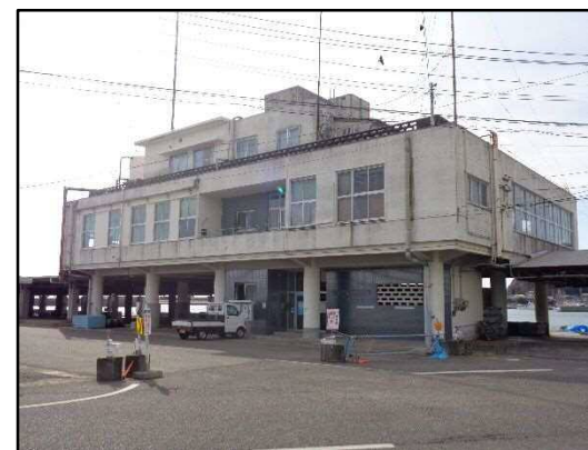
水産業強化対策整備事業費補助金 豊浜漁業協同組合 津波避難施設（組合事務所併設）整備事業 写真は、現在の豊浜漁業協同組合事務所が入った建屋
