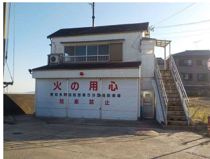
第5分団（日間賀島）東消防車庫建替工事
