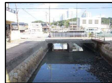
長寿命化修繕工事 郷中2号橋(片名)
