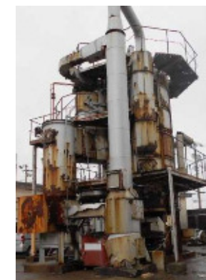
日間賀島旧し尿焼却施設
