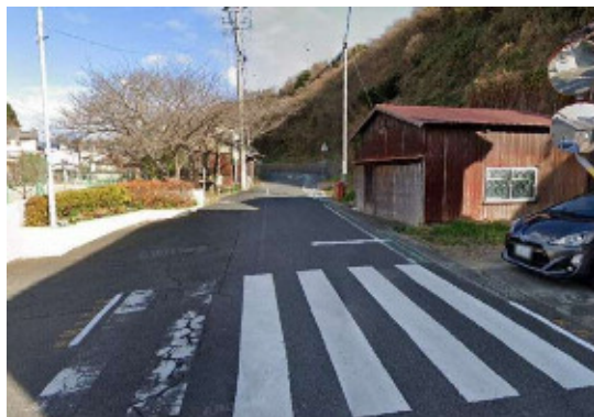
区画線（みさき小前）現況
