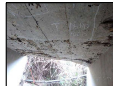
長寿命化修繕工事 赤田1号橋（大井）
