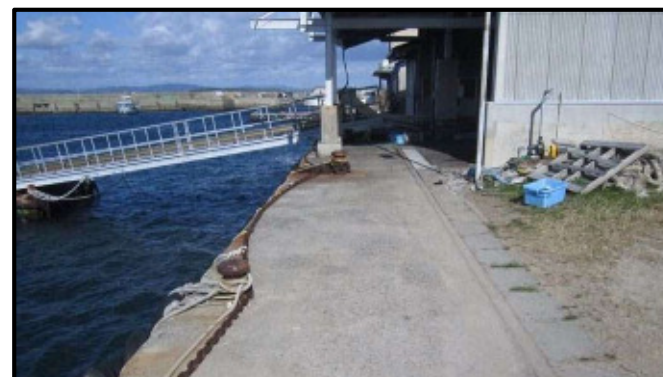
老朽化した物揚場の上部工改良【日間賀漁港】
