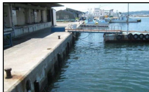
日間賀漁港の陸揚岸壁の耐震化
