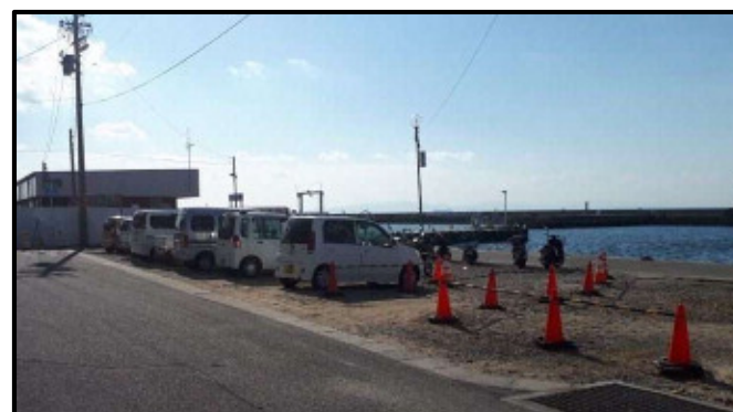
渡船場施設周辺の用地舗装【日間賀漁港】
