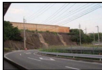
のり面修繕工事 町道須佐・山田線（豊浜）
