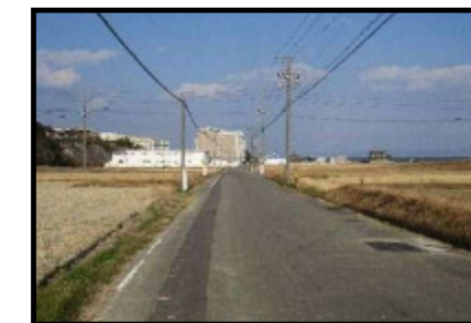
舗裝修繕工事 町道森添1号線（豊丘）
