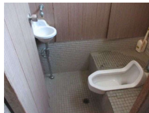
師崎小学校 体育館トイレ
