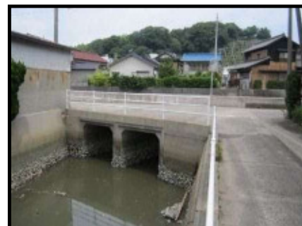
橋りょう点検調査 中浜田1号橋 始め50橋
