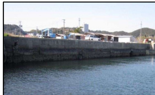
大井漁港の老朽化した物揚場補修
