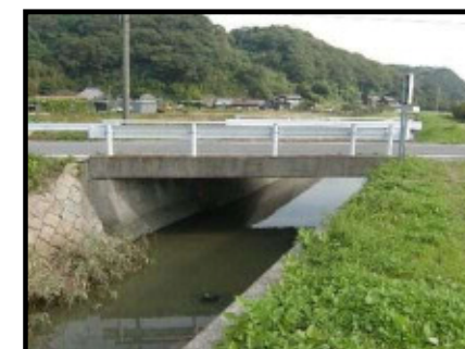
長寿命化修繕工事 月の輪橋 始め3橋
