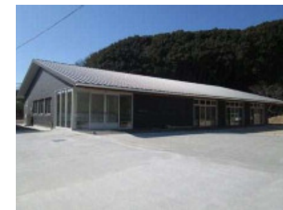
・内海防災センター
