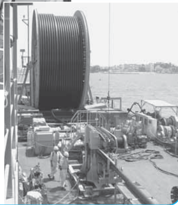
（師崎－日間賀島間 南ルート） 口径150 mm 海底管 （鋼帯がい装ポリエチレン管） 布設延長 2,041 m
