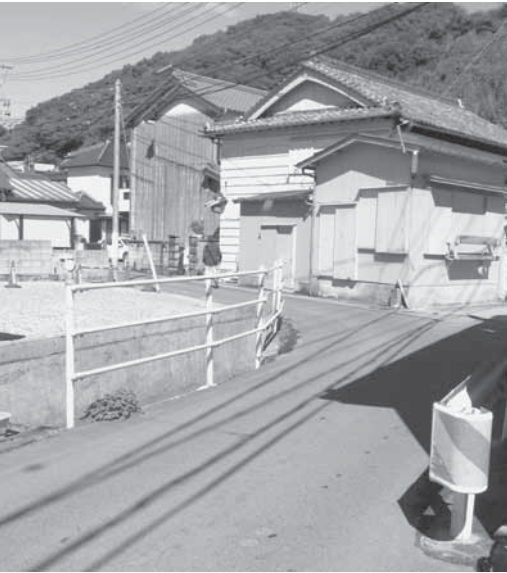
▲改修が待たれる かるも保育所付近の道路
