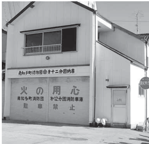
▲消防第十二分団詰所（日間賀島）
