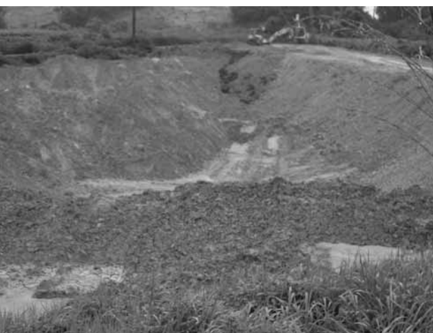
▲土砂採取現場の状況
