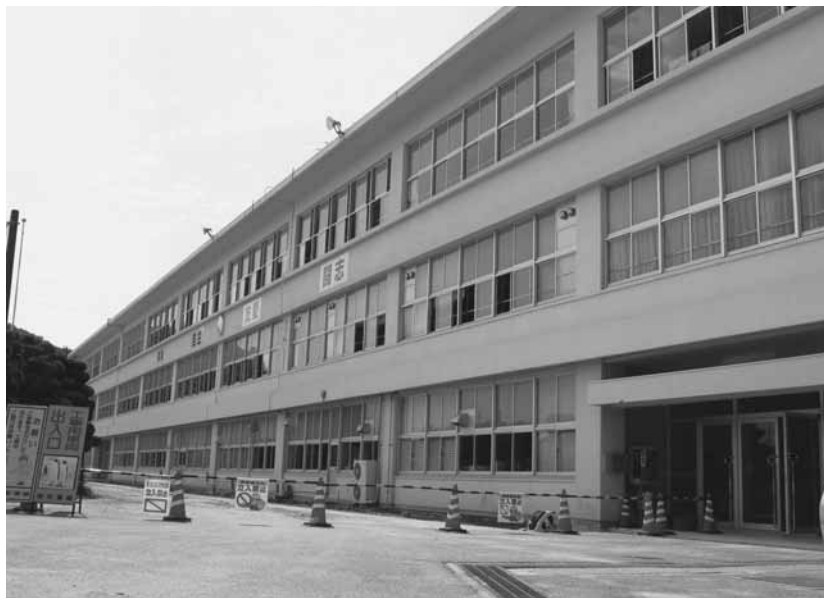
▲内海中学校本校舎（耐震補強及び外壁等改修工事）
