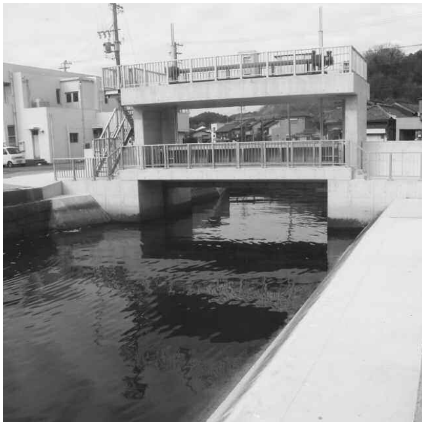
▲第3号防潮樋門（大井川）
