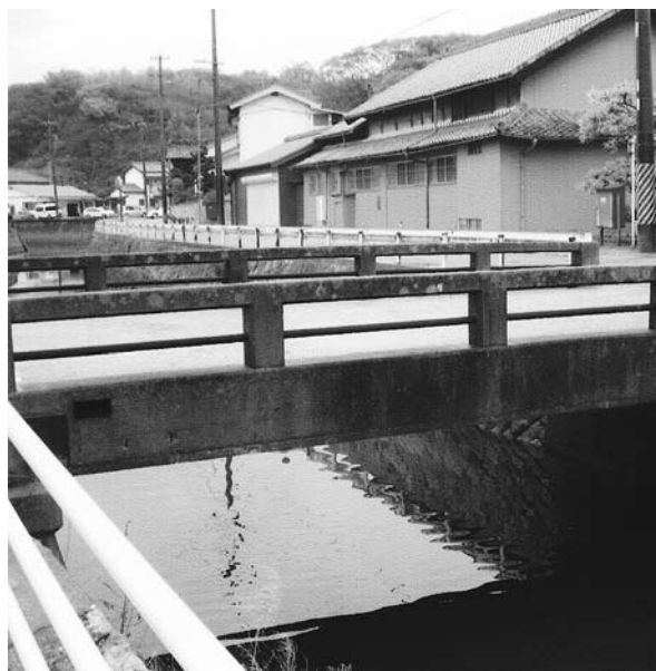
▲内海川に架る橋
