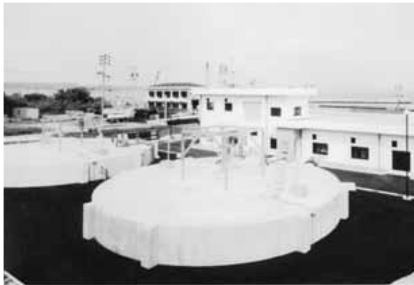
▲漁業集落排水事業・日間賀島浄化センター
