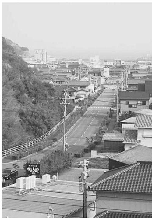
▲早期の全線開通が望まれる 都市計画道路「豊丘・豊浜線」
