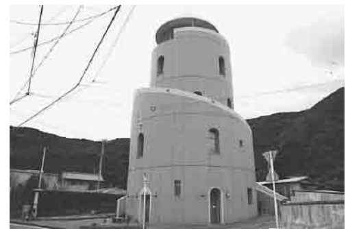
▲三重県大紀町の津波避難タワー
