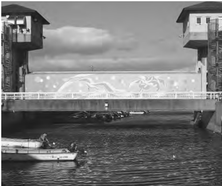
▲内海川の樋門
