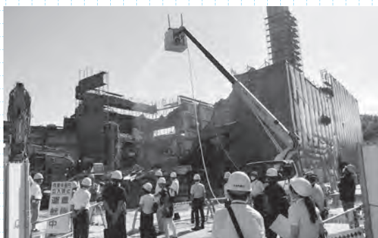
▲施設解体が進む知多南部クリーンセンター焼却施設
