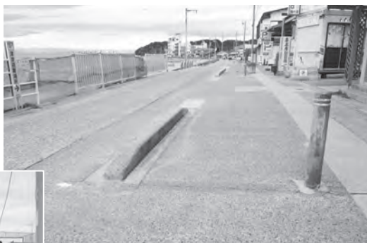
▲内海海岸道路の歩車道境界ブロック
