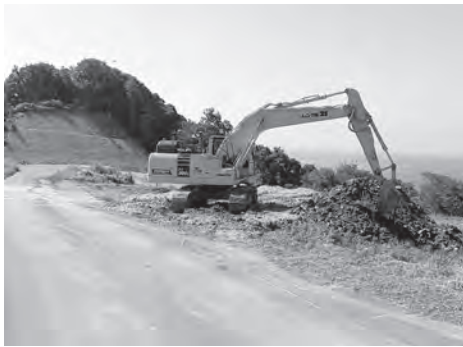
▲工事の着手状況
