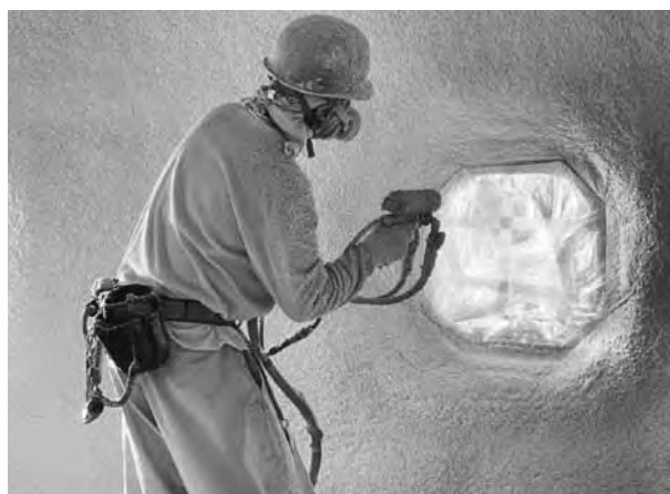
▲インスタントハウス吹付
