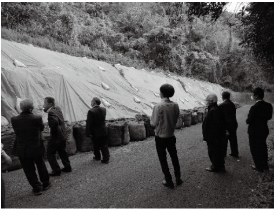
豊浜西狭間道路災害復旧工事状況
