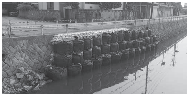
崩壊箇所の応急措置状況
