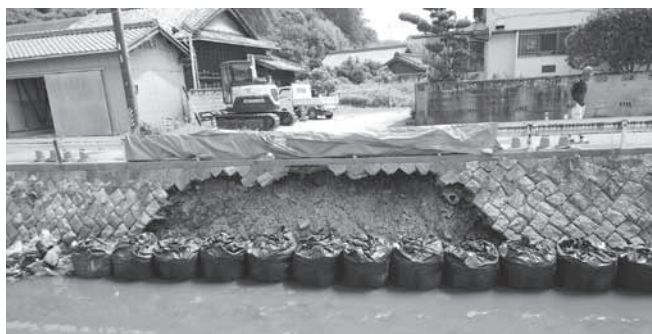
内海川の崩壊箇所
