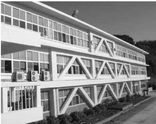
耐震化工事（大井小学校）
