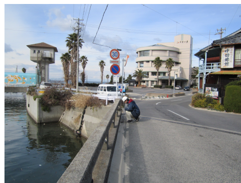
写真-3.4 職員による目視点検
