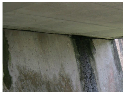
写真-3.2 専門業者による点検状況
