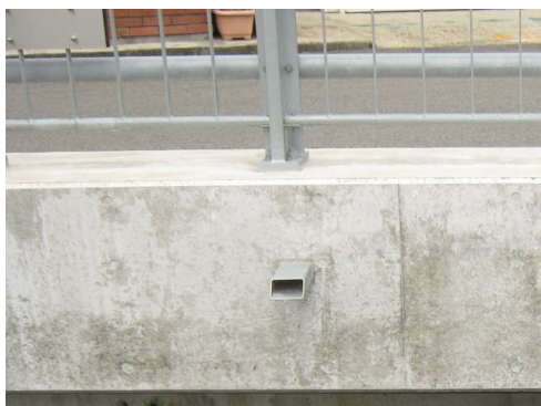
写真-3.1 専門業者による点検状況
