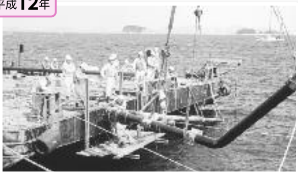
▲ 師崎～篠島間海底送水管布設替工事完工
