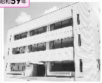
▲保健センター竣工
