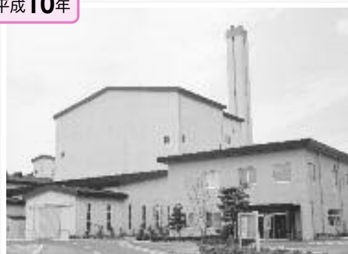
◀ 知多南部クリーンセンター完成
