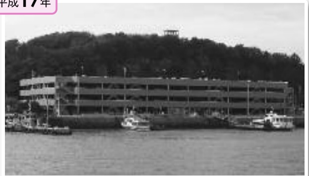
▲師崎港駐車場竣工
