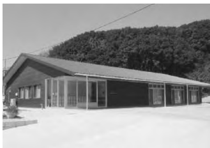
内海防災センター
