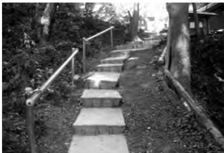
●利屋区避難路整備
