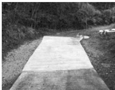
楠区・名切区：路面舗装
