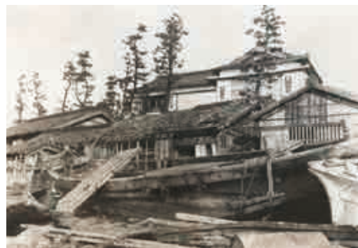
伊勢湾台風の被害状況（日間賀島）
