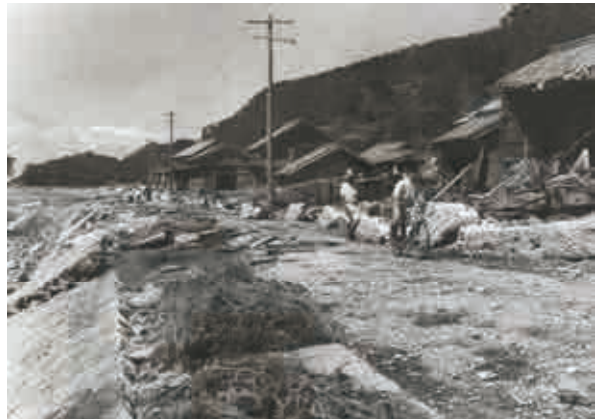
台風13号（昭和28年（1953））の被害状況（山海）
