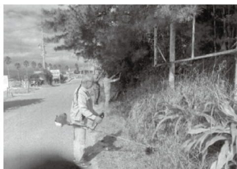
西端区：補助金を利用して草刈り機を購入し、避難路の整備を実施
